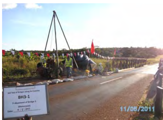
写真 6.3.1 地質調査状況(BH3-1)
