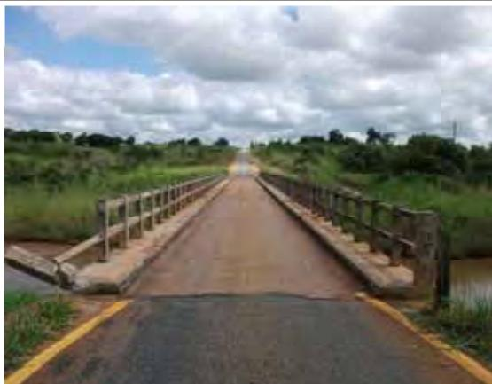
2. ムリケラ橋 ナンペボ側よりクアンバ側を撮影。コンクリート高欄一部損傷あり。
