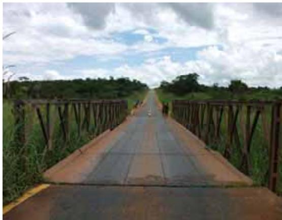
3. マタカシ橋 ナンペボ側よりクアンバ側を撮影。旧橋桁が落橋しており、仮設橋が架設されている。
