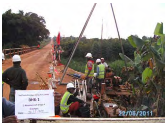
写真 6.3.3 地質調査状況(BH6-1)
