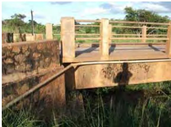
写真 2.1.1 ケーブル用添架管(ムタバシ橋)
