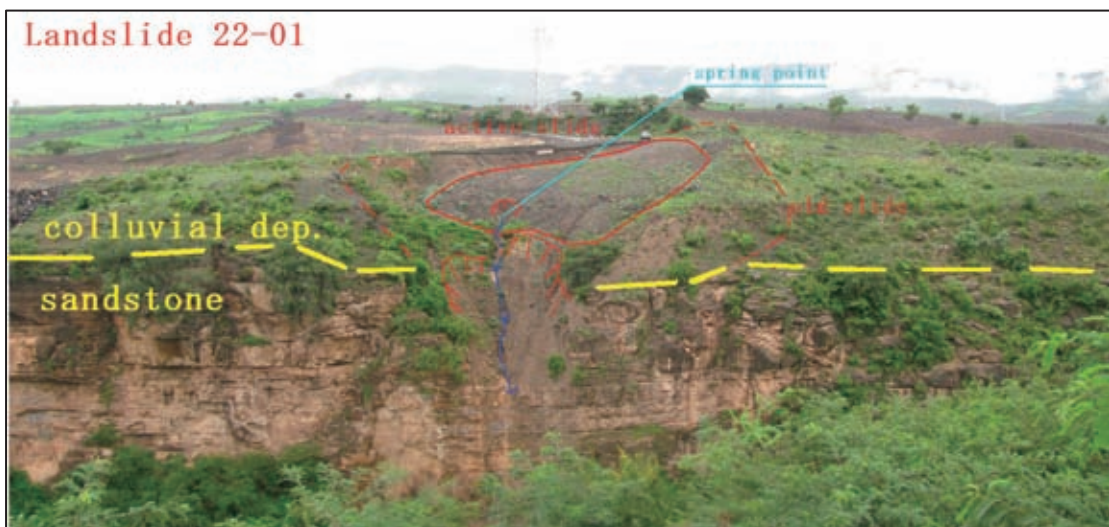
写真3.10.1 対岸からの地すべり 22-01 状況
