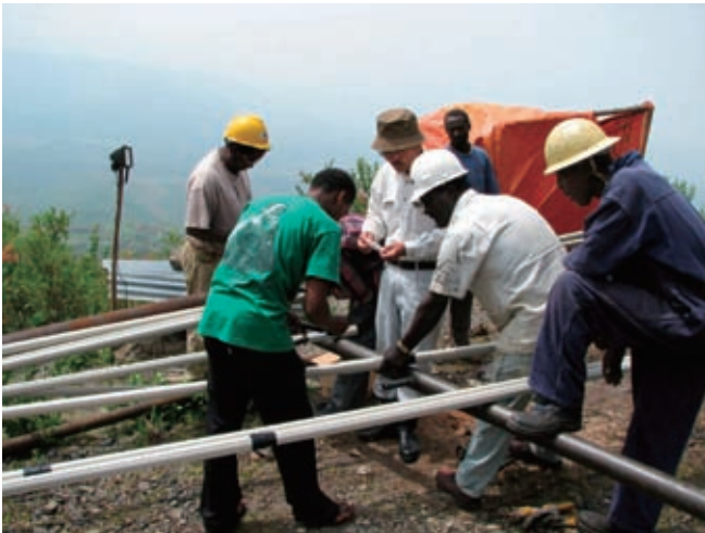
孔内傾斜計設置のためのケーシングパイプ組立作業の技術移転、2011年7月13日
