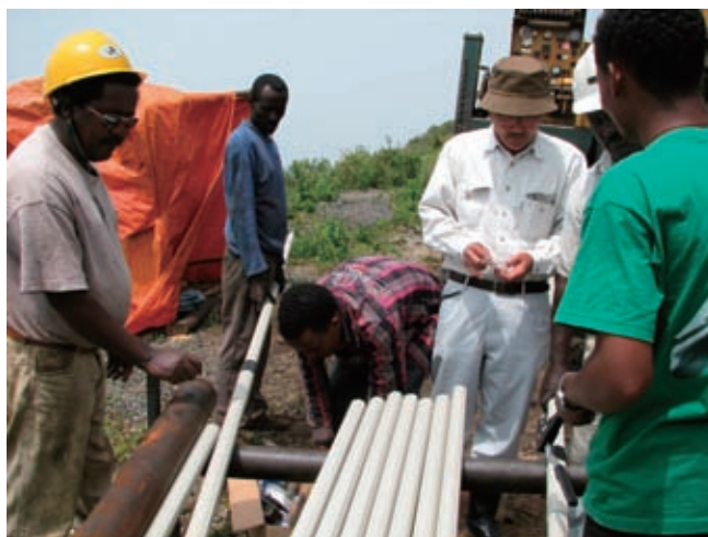
孔内傾斜計設置のためのケーシングパイプ 組立作業の技術移転、2011年7月13日
