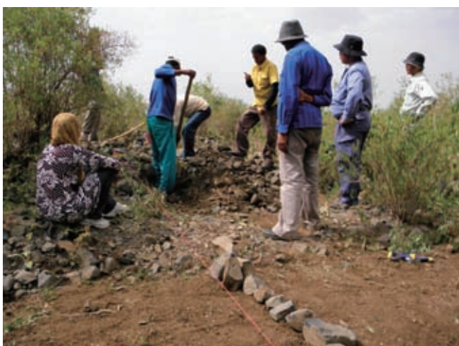
伸縮計設置のための側溝掘削工事作業
