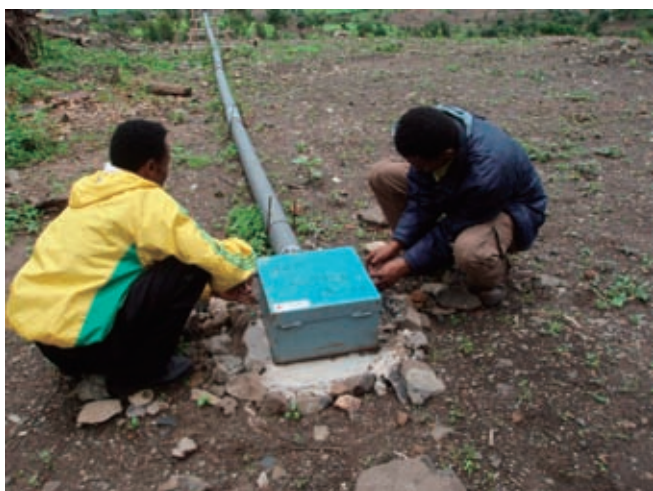
地すべり地帯での伸縮計の設置作業
