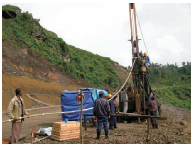
掘削作業（地点 ST. 0. 800）
