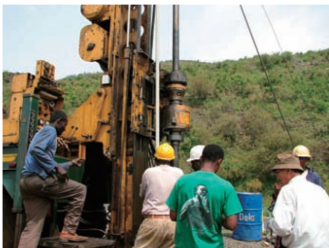
掘削技術移転及び傾斜計設置のためのケーシング パイプ組立作業の技術移転、2011年7月12日
