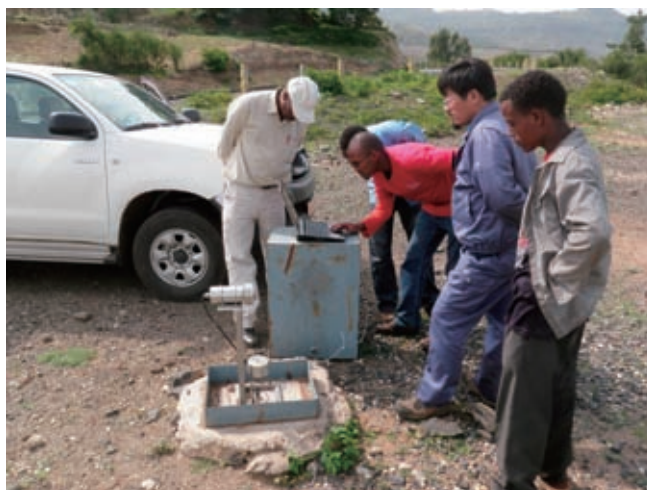
孔内伸縮計モニタリングデータ回収作業 2011年6月21日
