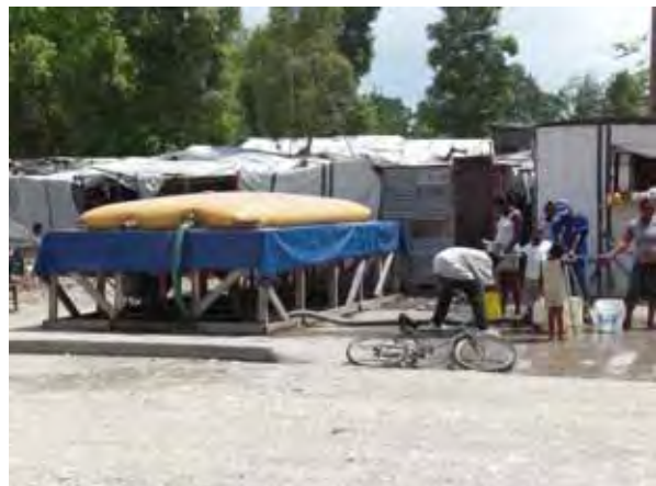
Figure D3-1 Réservoir d'eau en plastique et fontaine publique provisoire
