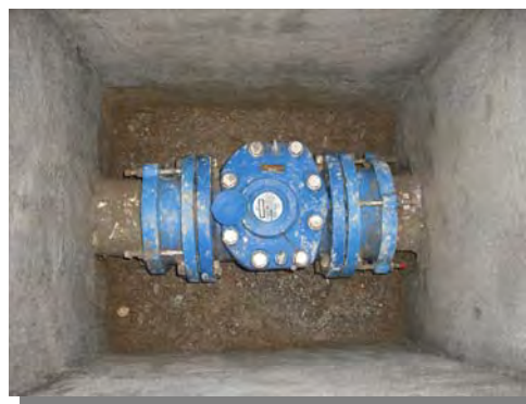
Photo: compteur d'eau
