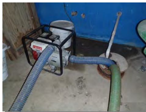
Photo: Source d'eau et Pompe
