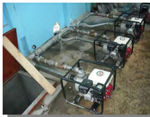
Photo: pompes de pressurisation (incomplètes)
