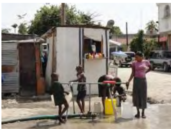
Photo 3: L'eau sera distribuée aux habitants par les installations provisoires à côté d'un bladder. (juillet 2010)
