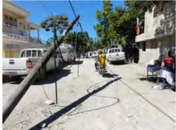
Photo 2 : Des poteaux électriques sont tombés un peu partout dans le centre-ville et le réseau électrique reste hors-services. (novembre 2010)
