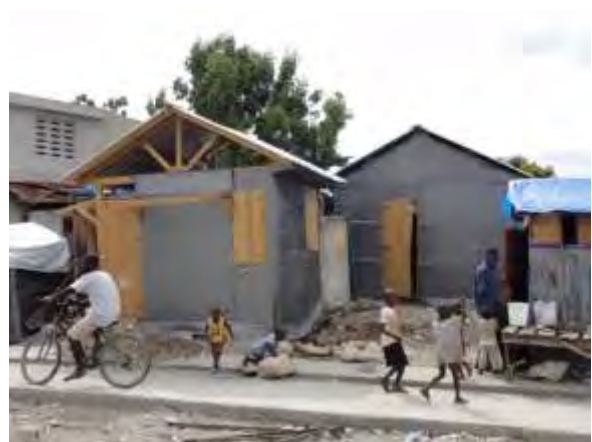
Photo 6 : Des habitations provisoires se construisent peu à peu. (septembre 2010)
