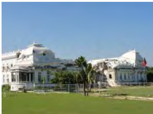
Photo 1: Palais national détruit par le Grand Séisme. (novembre 2010)
