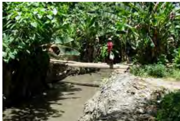
Photo 6: Canal décollant du centre-ville vers la ligne côtière. Insuffisamment aménagé, il nécessite un curage. (juillet 2010)
