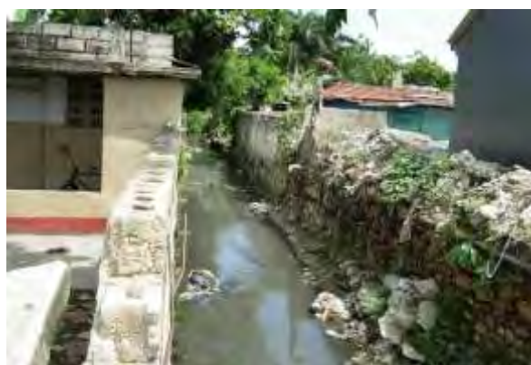
Photo 5: Canal d'écoulement du centre-ville. Insuffisamment aménagé, il nécessite un curage. (juillet 2010)
