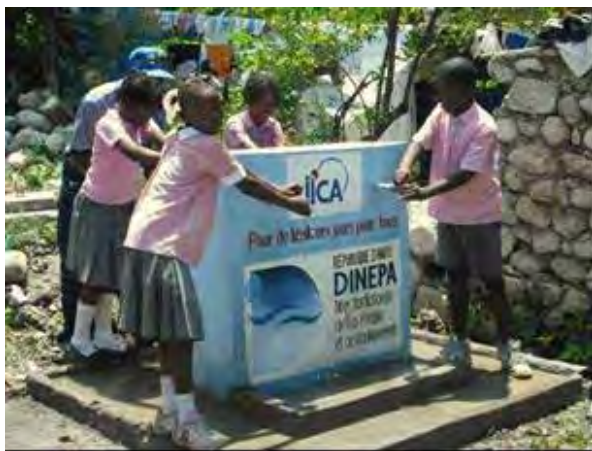
Fontaine publique installée au sein de l'école
