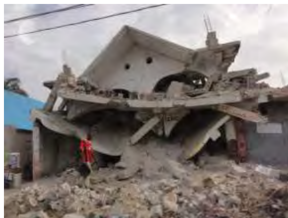
Photo 4: Des décombres de maisons détruites sont encore laissés à Port-au-Prince. (juillet 2010)
