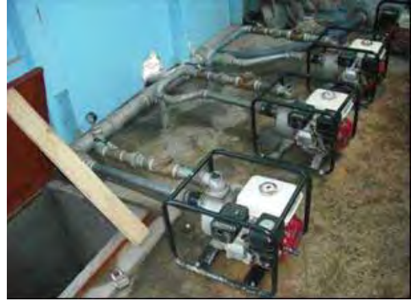
Pompe moteur pour l'alimentation en eau
