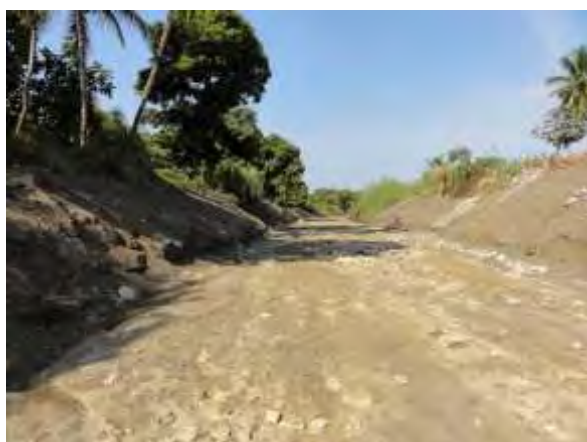
Photo 5 : La boue amenée en permanence de l'amont s'entasse sur le lit de la Rouyonne, ce qui nécessite des mesures drastiques. (janvier 2011)
