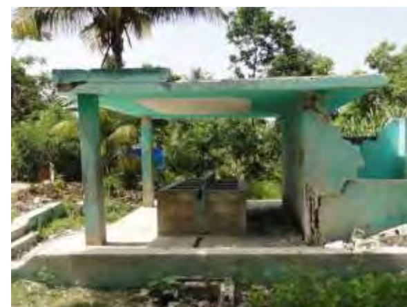
Photo 4: Les installations d'adduction d'eau (fontaine publique) de la banlieue de Léogâne endommagées par le séisme sont devenues inutilisables. (juillet 2010)
