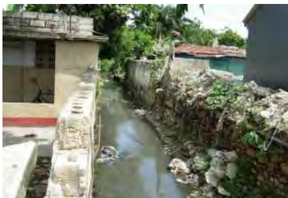
Photo 5: Canal d'écoulement du centre-ville. Insuffisamment aménagé, il nécessite un curage. (juillet 2010)
