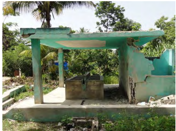
写真4: レオガン郊外の公共水栓施設も地震による被害を受けて使用不能となった (2010年7月撮影)
