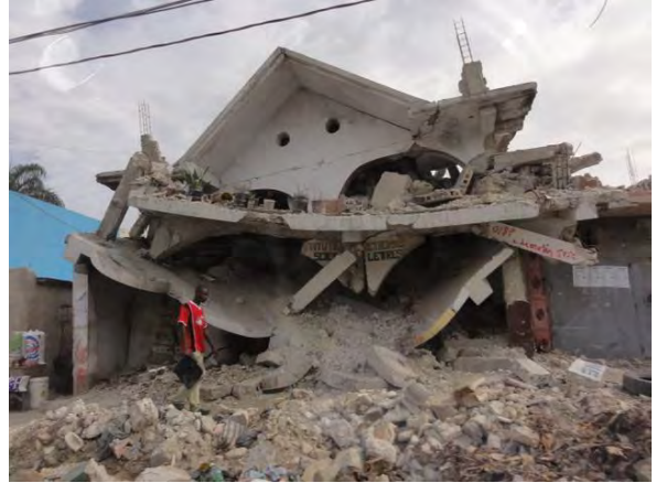
写真4: ポルトープランス市内には多くの倒壊家屋が瓦礫となったまま放置されていた(2010年7月撮影)
