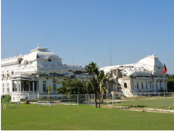
写真1: 倒壊した大統領宮殿(2010年11月撮影)
