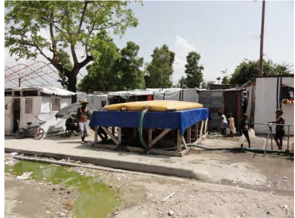
写真2: 被災者のキャンプ地等に bladder(ビニール製水タンク)を設置し、給水車から配水していた (2010年7月撮影)
