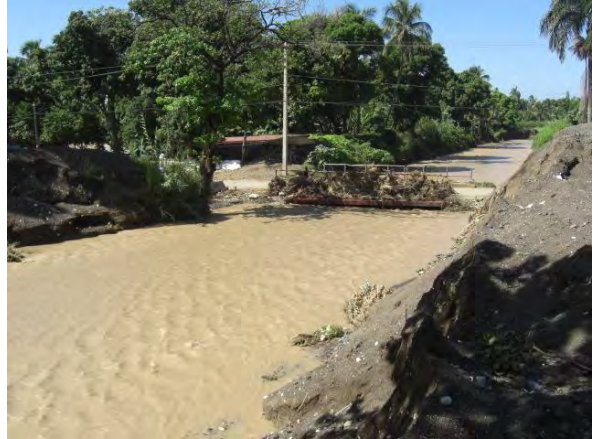
写真4: ハリケーン・トーマスで氾濫したモマンス川と旧国道が交錯する地点 (2010年11月撮影)
