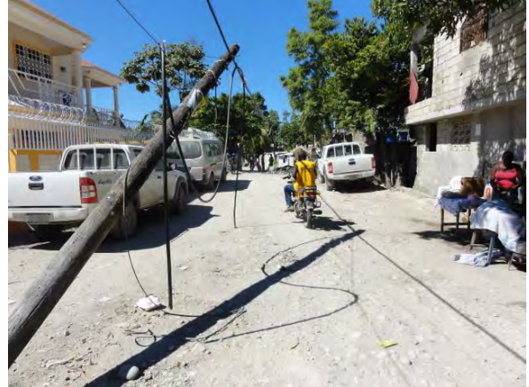
写真2: 至る所で電柱が倒れ、送電網は機能していない (2010年11月撮影)
