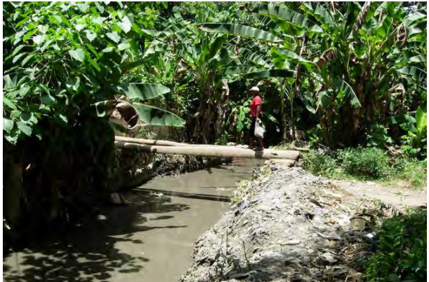
写真6: 市街地から海岸線への排水路。整備が不十分のため、改善が必要である (2010年7月撮影)
