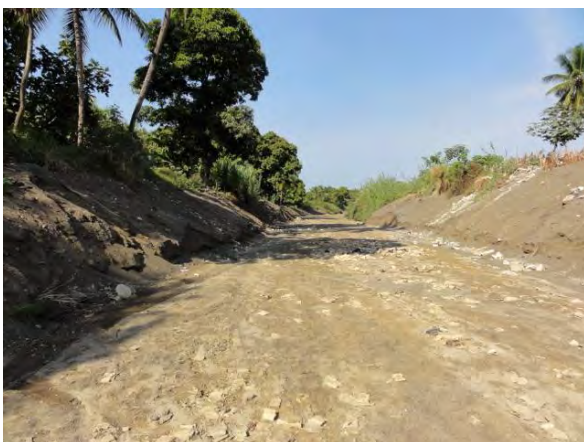
写真5: ルヨンヌ川の川床には上流からの土砂が慢性的に流れこんで堆積しているため、抜本的な対策が望まれる (2011年1月撮影)
