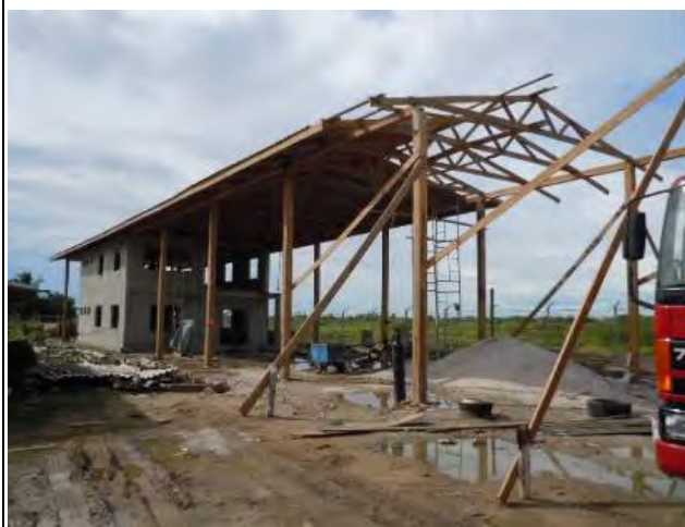
写真-6 建設中のワークショップ 調達機材の修理や維持管理に対応する。
