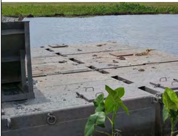
写真-4 台船の補修状況
