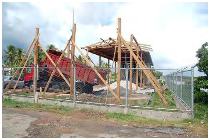
写真 2-1 ワークショップ建設状況(2010 年 10 月現在)
