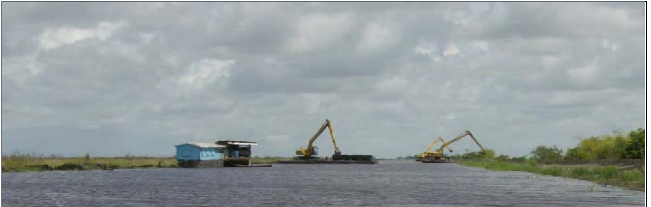
写真-1 修復材採取及び堤体修復の状況
