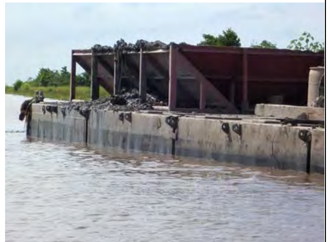
写真-3 用土収納槽付き台船
