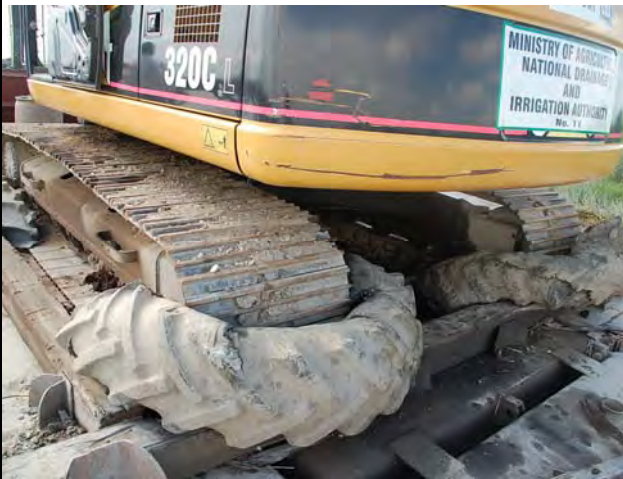
写真-2 掘削機のすべり防止対策
