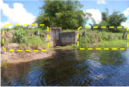
現況－老朽化の木製擁壁状況
