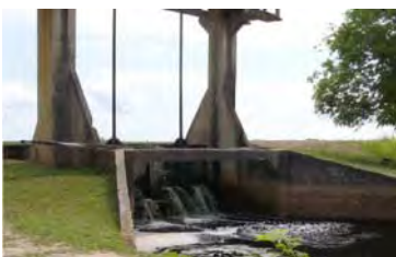
現況-2 ドア漏水状況(1)
