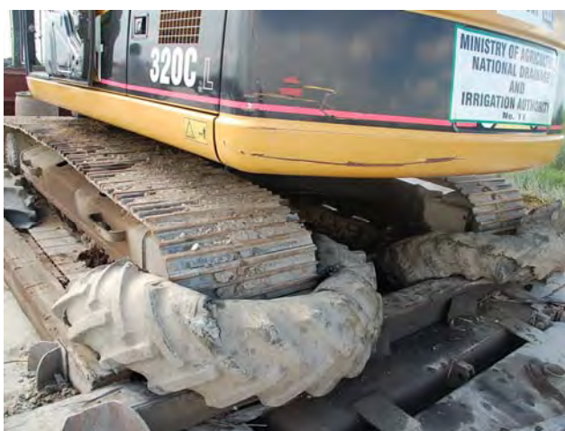
写真-2 掘削機のすべり防止対策
