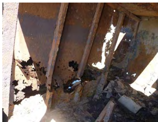
写真-5 廃船となった台船
