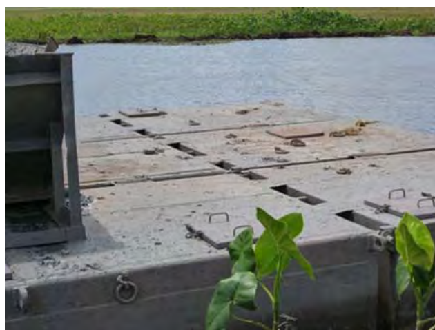
写真-4 台船の補修状況
