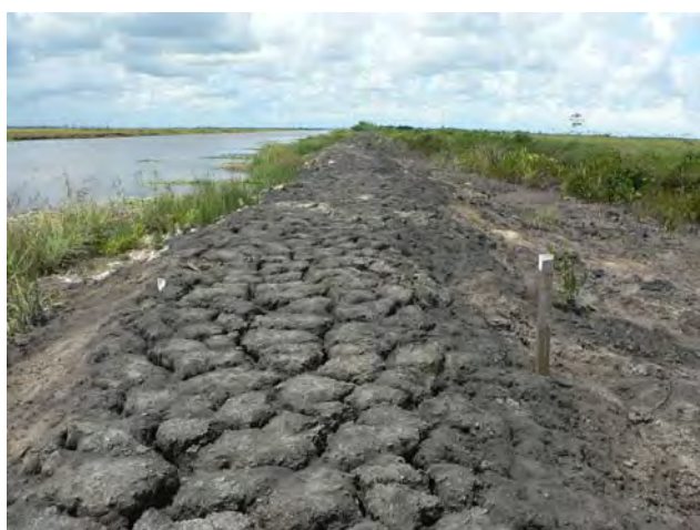
写真-10 修復後間もない堤体の盛土の状況 乾燥収縮による土塊間空隙の発生により、有機質土塊のブロック状盛土堤体となっている。
