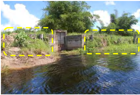
現況－老朽化の木製擁壁状況
