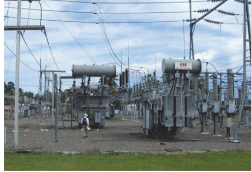
変圧器 (132/66kV,132/11kV)
