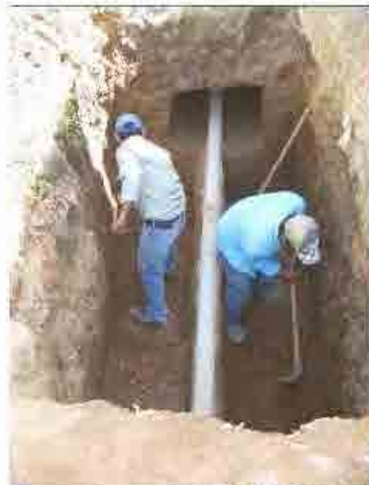
Inspección del tipo de tubería y diámetro
