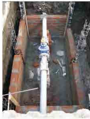
Construcción de paredes en cajas para válvulas
