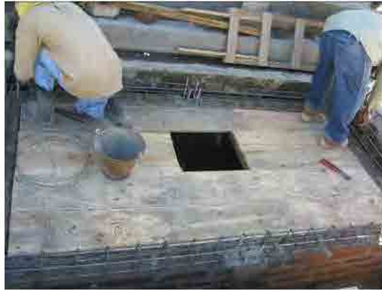
Encofrado para el colado de cajas
