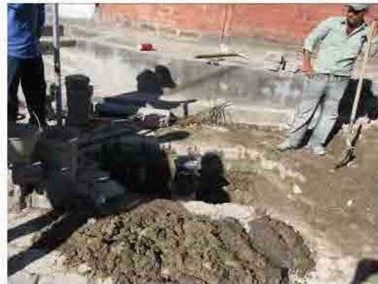
Instalación de cubre válvulas
