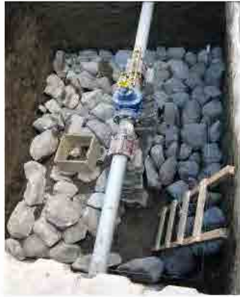
Colado de fundaciones para válvula
