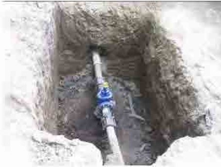
Instalación de válvula compuerta
