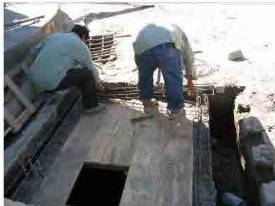
Encofrado para colado de cajas
