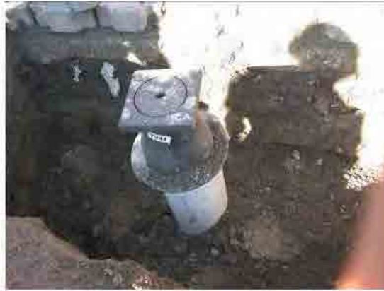
Instalación de cubre válvulas
