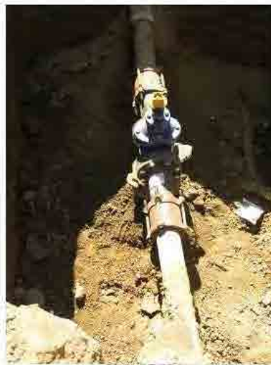
Instalación de válvula compuerta
