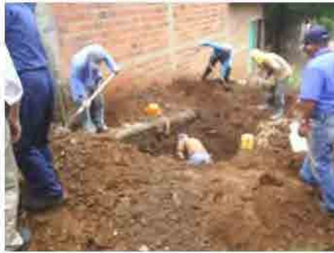
Excavación de caja de 2.4 x 1.5 x 1.80 metros.
