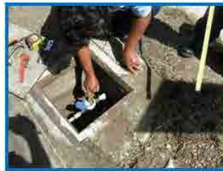
CAJA DE MEDIDOR FUERA DE NORMAS TECNICAS DE ANDA POR UBICACIÓN
