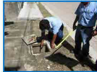
CAJA DE MEDIDOR FUERA DE NORMAS TECNICAS DE ANDA POR UBICACIÓN
