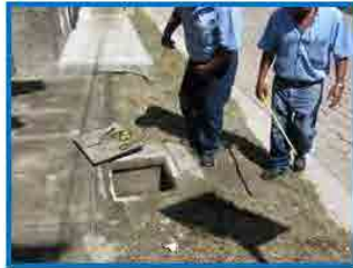
CAJA DE MEDIDOR FUERA DE NORMAS TECNICAS DE ANDA POR UBICACIÓN
