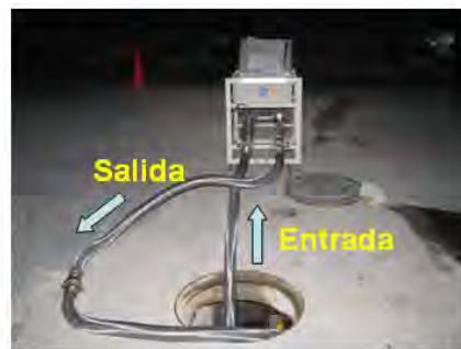
Conexión de tuberías
