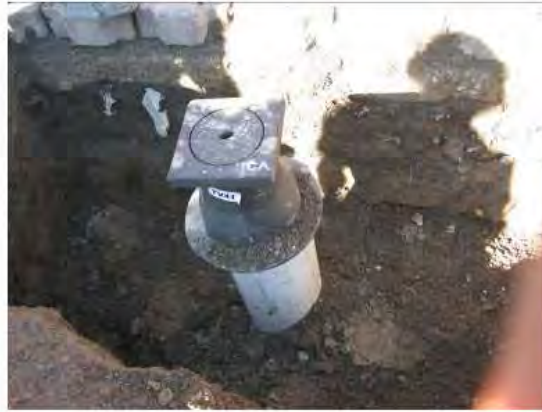
Instalación de cubre válvulas
