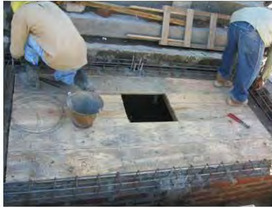
Encofrado para el colado de cajas
