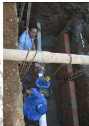
Colado de fundaciones para válvula
