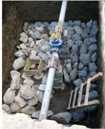
Colado de fundaciones para válvula
