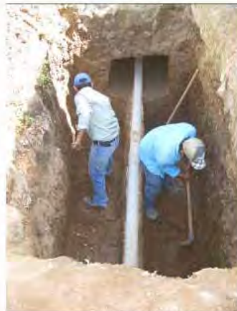
Inspección del tipo de tubería y diámetro
