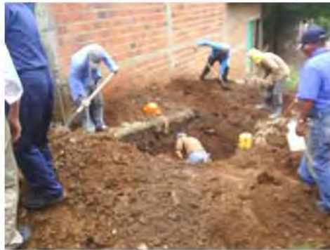
Excavación de caja de 2.4 x 1.5 x 1.80 metros
