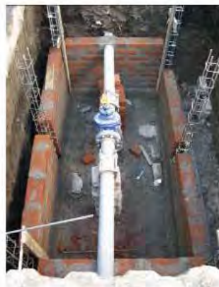
Construcción de paredes en cajas para válvulas
