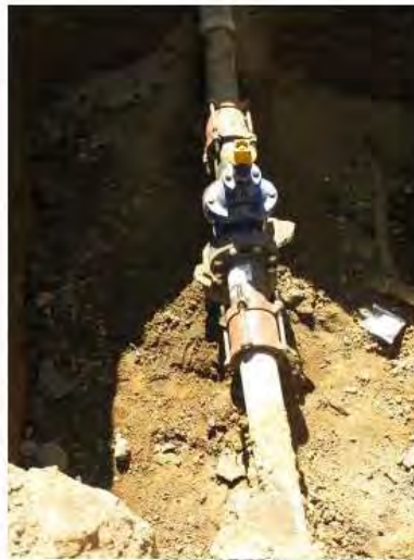
Instalación de válvula compuerta
