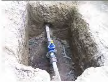
Instalación de válvula compuerta
