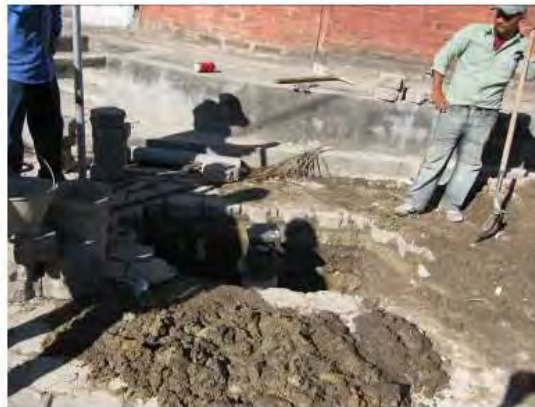
Instalación de cubre válvulas
