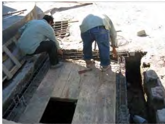
Encofrado para colado de cajas
