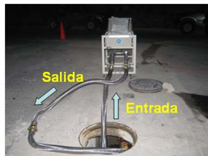
Conexión de tuberías
