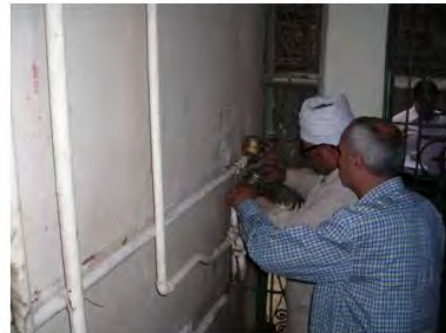
Reemplazo del Medidor
