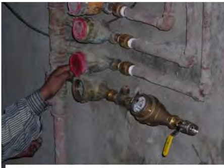
Conexión del medidor nuevo
