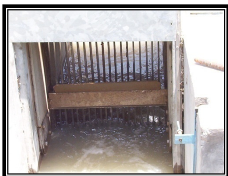
Fig. 3-3-1 Rejas de limpieza mecanizada con rastrillo
