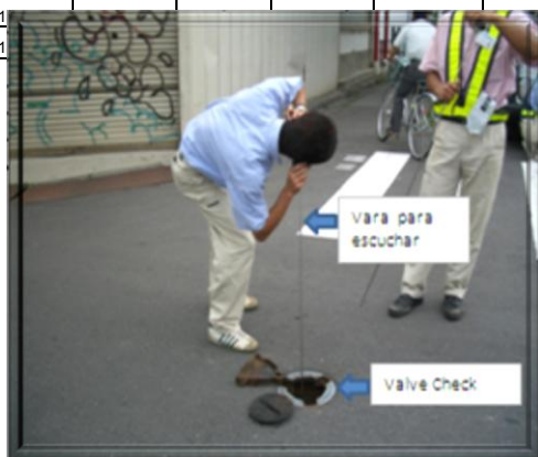
Figura 21: Revisión de válvulas de control
