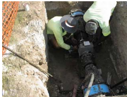
Fig. B7.6 Instalación de medidor de distrito
