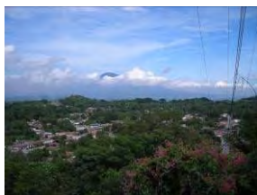
配水池より区画を望む
