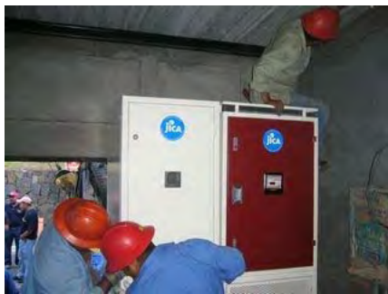
パイロット施設 1:ANDA 本部受変電施設への 力率改善機器の設置工事の様子
