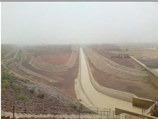
Goronyo ダムから取水した農業用水路の状況。
