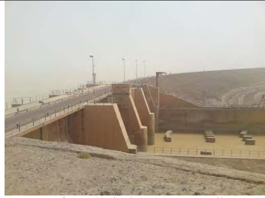
Goronyo ダムの放流ゲート付近の堤体状況。
