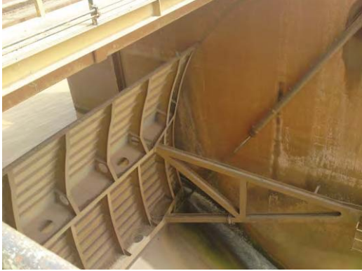
Goronyo ダムの放流ゲートの状況。
