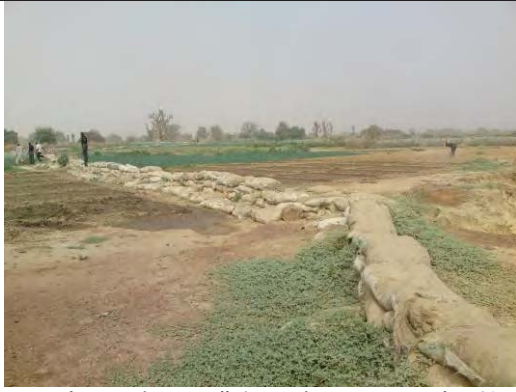
Goronyo ダム下流側の灌漑区域の状況。ダム放流水による洪水対策のための土嚢が積まれている。
