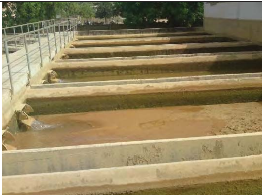
Zamfara 水公社の浄水場の水処理状況。原水は Gausa 堰から沈砂池を経て浄水場に導水される。濁度が高い。
