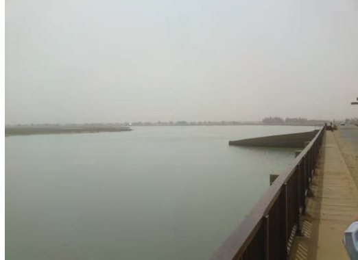
Gausa 堰の貯水池の状況。平坦な地形であるため堰長は 1km ほどに達する。
