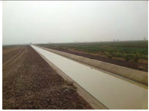
Goronyo ダム下流側の灌漑用水路の状況。整備状況は極めて良好であり維持管理能力の高さが伺われる。
