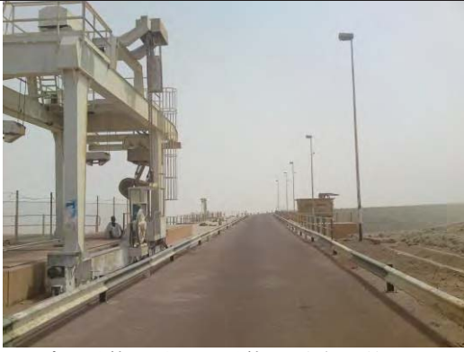
Goronyo ダム堤体の状況。堤体の長さは約 5km である。
