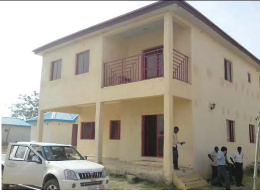
Sokoto - Lima 川流域 CMO の事務所の状況。2010 年に設置され、現在職員は 13 名である。
