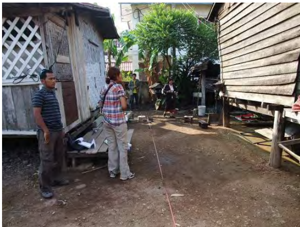
ວັດແທກ ຈຸດທີ່ຈະກໍ່ສ້າງອ່າງ DEWATS ໂດຍການສຶກສາ ຄວາມເປັນໄປໄດ້ເບື້ອງຕົ້ນ
