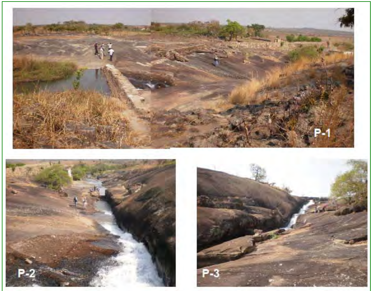
写真 3.2-4 Põe 川地点の全景写真(乾季:2010年9月10日撮影)
