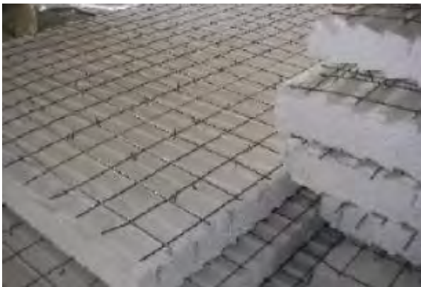
写真 4.4-5 下地を予め組み込んだ壁断熱材
