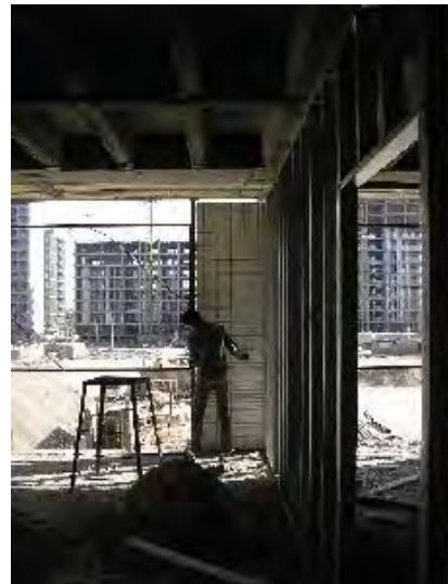
写真 4.4-6 断熱材の施工風景 （軽量鋼フレームへのはめ込み）
