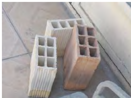
写真 4.4-2 イランにおいて一般的な建材の例（中空レンガ）
