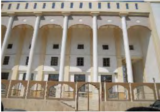
写真 4.4-10 庇による日照の遮蔽
