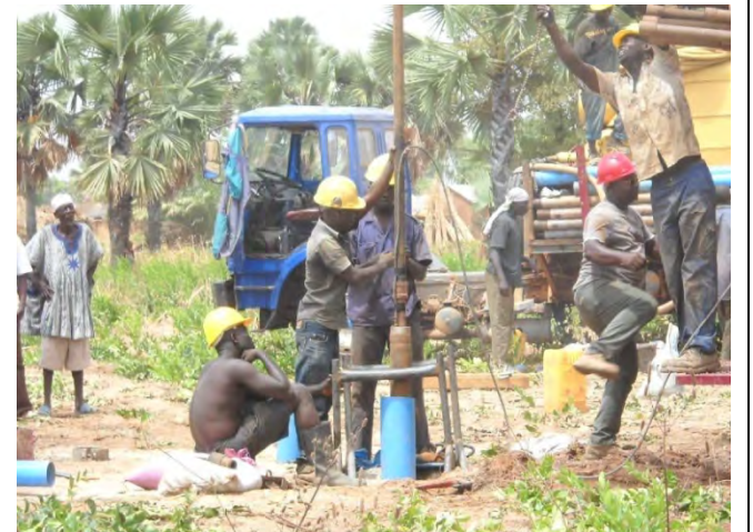
写真-12 試掘調査状況（計画対象地区：サバナス州トン県ナキウスト村）
