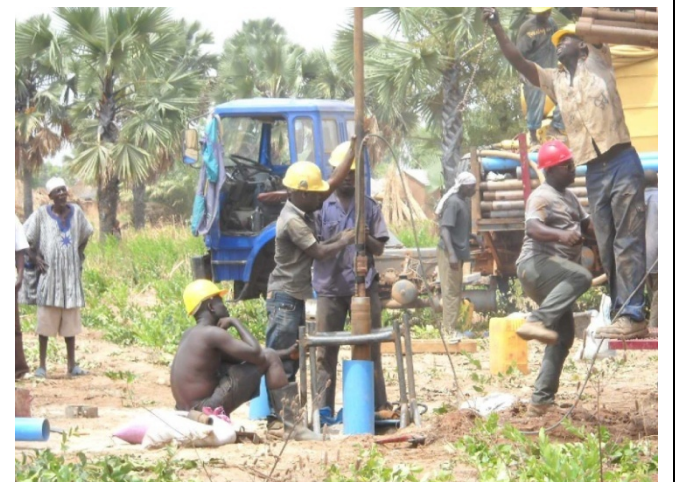
写真-12 試掘調査状況（計画対象地区：サバナス州トン県ナキウスト村）
