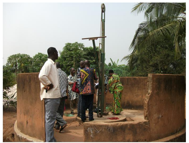
写真-4 日本の「村落給水計画(1997～2000年、第4次無償)」で建設された人力ポンプ付給水施設(マリタイム州ケベオ村)
