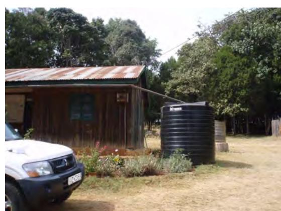
(写真-12) マリガット県、トタン屋根を利用して降雨を貯留するタンク。
