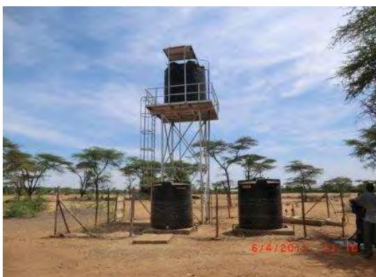
(写真-9) マリガット県、ソーラーシステムが利用されているとともに、NGO による骨炭のフッ素除去が行われている。
