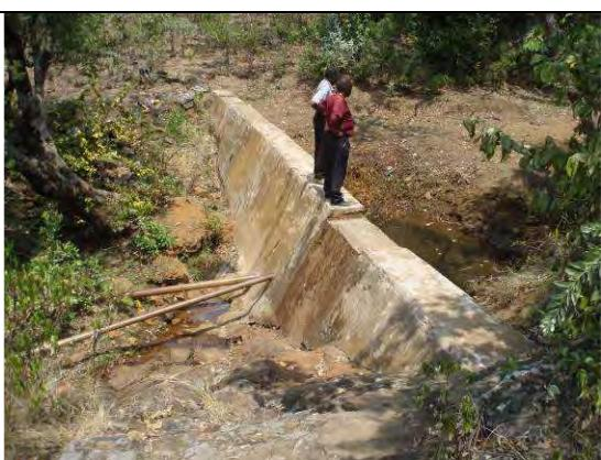
(写真-3) 中央バリンゴ県の湧水施設。堰を設けて亜鉛めっき鋼管にて自然流下により送水。乾季は水量不足となる。
