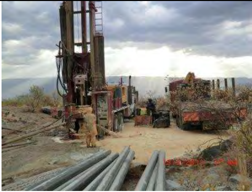
(写真-15) 試掘サイト 110。深度 70m 付近の掘削状況。揚水試験の結果、 2.5\text{m}^3/\text{h} 以上で本プロジェクトへ活用が可能。
