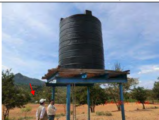
(写真-11) 中央バリンゴ県、発電機使用による給水施設。水槽は小学校の校舎付近に設置され、井戸および発電機室は写真左奥。
