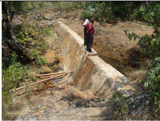
(写真-3) 中央バリンゴ県の湧水施設。堰を設けて亜鉛めっき鋼管にて自然流下により送水。乾季は水量不足となる。
