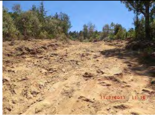
(写真-16) 山岳部のアクセス道路。路面に岩が露出し最低速度による走行となる。
