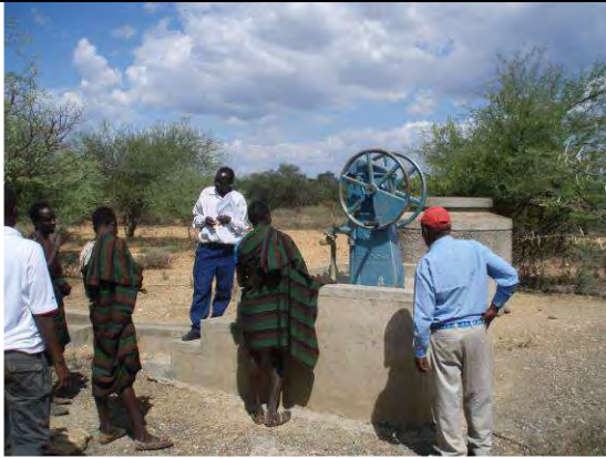
(写真-13) 東ポコット県にあるハンドポンプ。当初は水が出たが、住民によると最近では水位が低下して水が出ないため使用していない。
