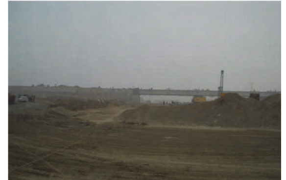
GT Road と Ring Road の交差点 (建設中)
