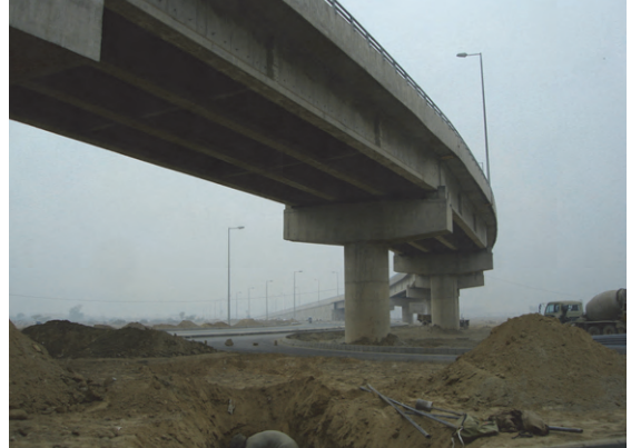
Defence Road からの空港アクセス (高架)
