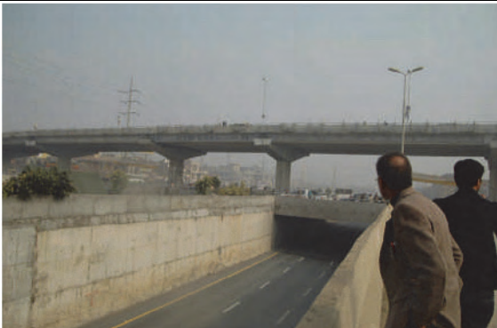
Canal Road と Link Road との立体交差
