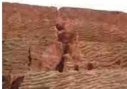
Ocorrência de erosão na camada amarela avermelhada no terreno onde houve corte de encosta no município de Pomerode. Fragiliza-se facilmente com a água infiltrada e fica sujeita a erosão.
