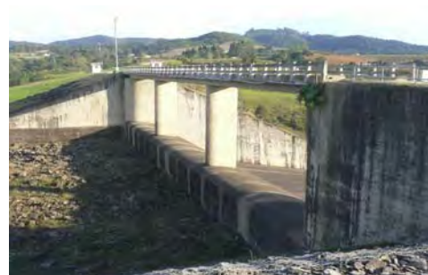
Sul ダムの余水吐
