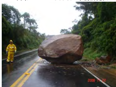
2008年11月豪雨による被災 連邦道路 BR470 号線 Blumenau 市内赤黄色土中の長径5m大の岩塊が回りの土壌が含水し、劣化したため抜け落ち道路へ転落した。
