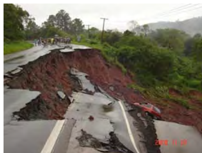
2008年11月豪雨による被災 連邦道路 BR470 号線 Km 41 Gaspar 市内赤黄色土のうち赤色土を主体とする路体が突発的に崩壊し、走行中の自動車が落下した。
