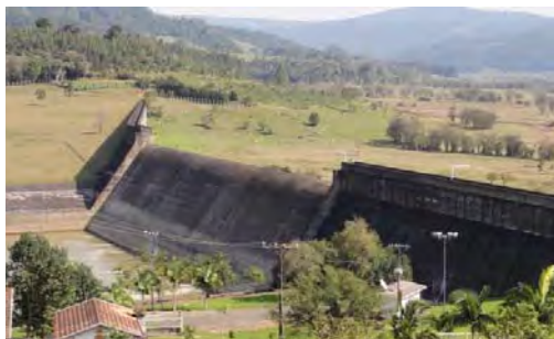
Oeste ダムの余水吐
