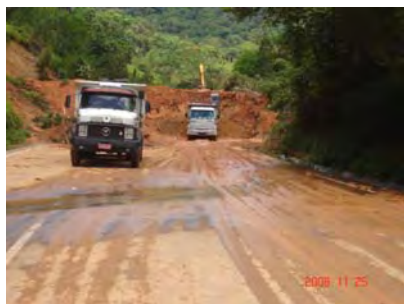
2008年11月豪雨による被災 連邦道路 BR470 号線 Km 44 Blumenau 市内赤黄色土の崩土が道路を完全に閉塞した。
