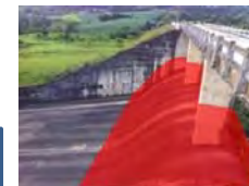
Sulダム洪水吐きの高上げ (高上げ高2.0 m)
