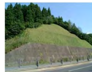
施工2年後の様子(上部斜面が連 続繊維補強土工法を施工)
