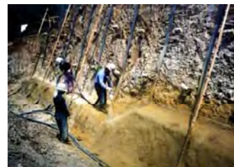
連続繊維補強土工法の施工例
