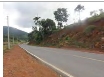
Visão geral do talude na lateral de Luiz Alves
