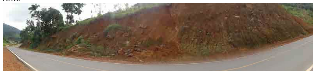
Visão geral do talude na lateral de Luiz Alves
