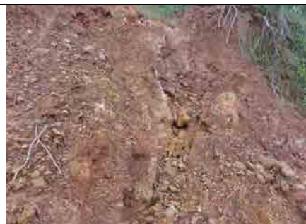
Rachaduras com extensões paralelas a estrada se encontram no talude. É descoberta a infiltração da água nestas rachaduras.
