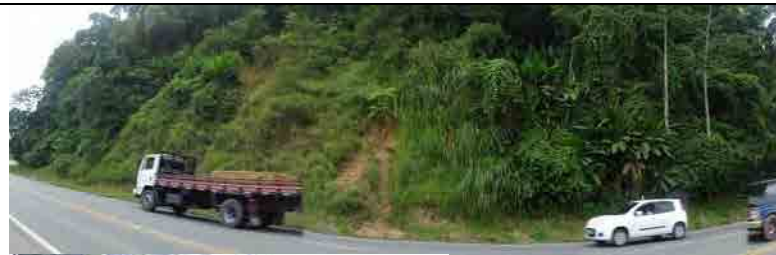
Deslizamento de terra no centro do talude
