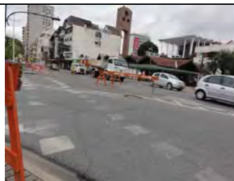
Rachaduras no pavimento da estrada
