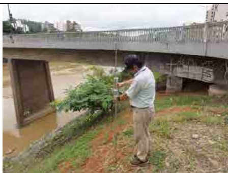
Parte do lado da Estrada, sondagem com o cone dinâmico de penetração
