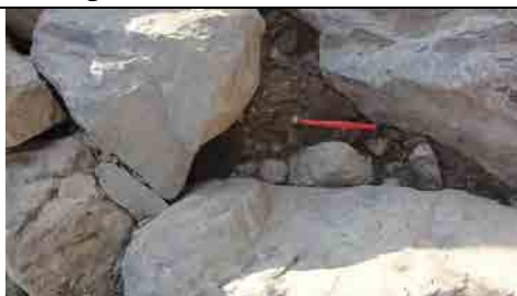
Trabalhos nos escombros do depósito do talude. (solo de granulometria fina com pedregulhos, alguns pedregulhos estão intemperizados e moles.
