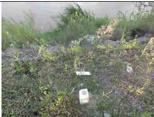
Situação do talude da parte mais deformada Seção transversal mostrado na Figura 6.5.7.
