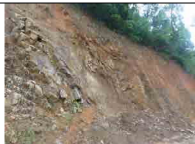
Estrutura de junta é N10W 70Wdip, levemente oblíqua à superfície do talude. Rocha dura de granulito.
