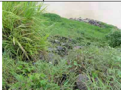
Proteção temporária dos taludes com gabiões
