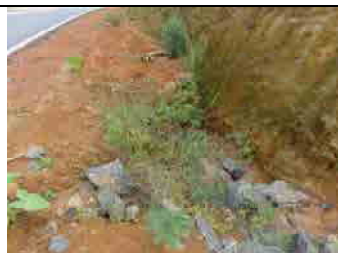
Pé do talude na lateral de Luiz Alves
