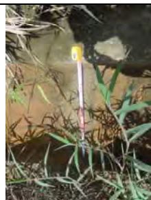
O talude possui uma vala de 60 cm largura e 60 cm profundidade.
