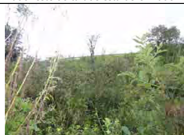
Situação do lado leste do talude
