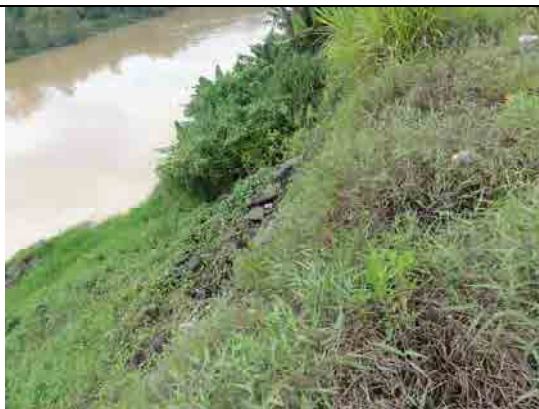
Proteção temporária dos taludes com gabiões
