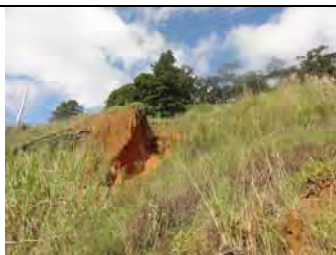
Erosão na lateral do talude do vale na parte de Gaspar.
