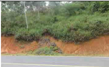
Estrutura de junta é N10W 70Wdip, levemente oblíqua à superfície do talude. Rocha dura de granulito.
