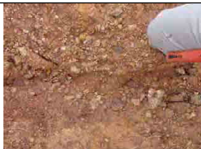
Rachaduras com extensões paralelas a estrada se encontram no talude. É descoberta a infiltração da água nestas rachaduras.
