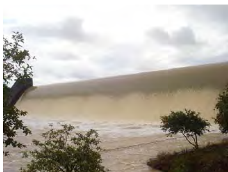
Situação de transbordamento da barragem Oeste
