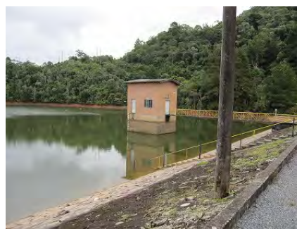
Torre de tomada d'água da barragem Pinhal
