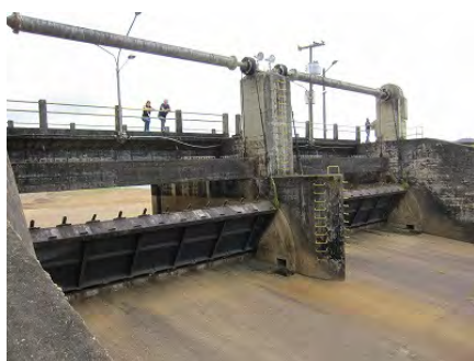
Comportas do vertedouro da barragem Rio Bonito
