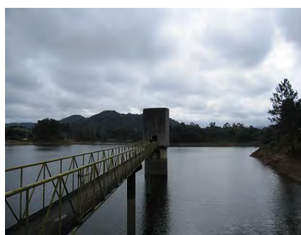
Torre da tomada d'água da barragem Rio Bonito
