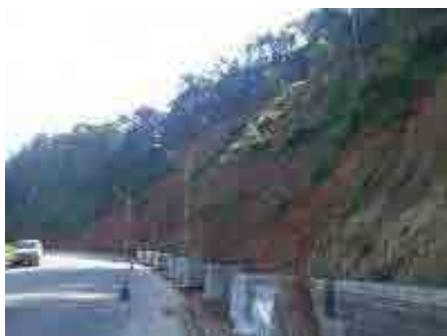
Local de obra de prevenção de desastre na estrada municipal de Blumenau, executada pelo DEINFRA. Desmoronamento da camada fina do solo vermelho e amarelo que cobre a rocha de embasamento.
