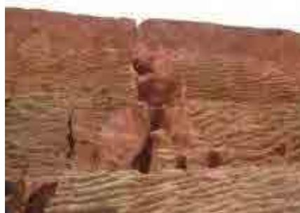
Ocorrência de erosão na camada amarela avermelhada no terreno onde houve corte de encosta no município de Pomerode. Fragiliza-se facilmente com a água infiltrada e fica sujeita a erosão. Foto: Equipe de Estudo da JICA, maio de 2010.
