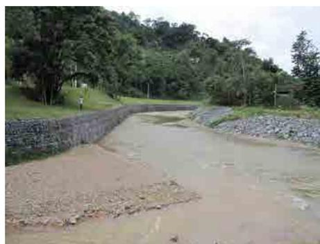
Obra de proteção em gabião na margem do Ribeirão Garcia, após enchente de 2008, em Blumenau
