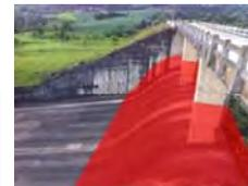
Sobre-elevação do vertedouro da Barragem Sul (Altura de 2.0 m)
