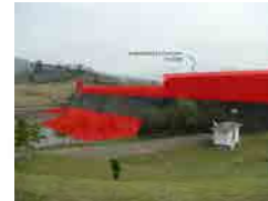
Oesteダムの高上げ (高上げ高2.0 m)
