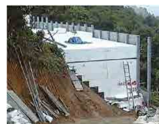
日本の山岳道路における EPS軽量盛土を用いた盛土の事例
