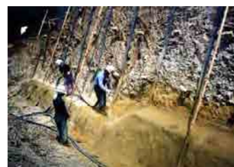
連続繊維補強土工法の施工例
