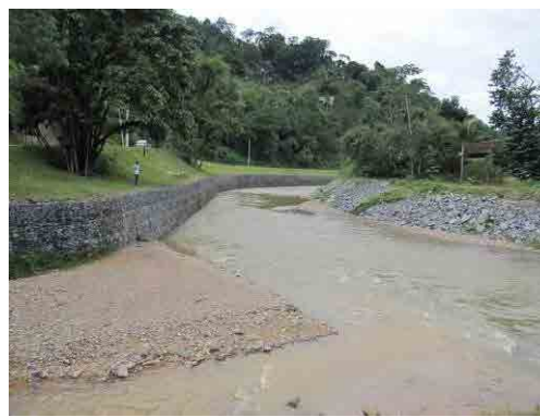
写真：Blumenau 市街地右岸の護岸（左）、2008 年洪水後の災害復旧工事で整備された支川 Garcia 川のかご工（右）
