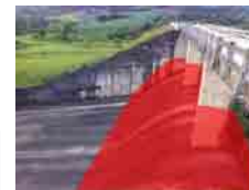
Sulダム洪水吐きの高上げ (高上げ高2.0 m)
