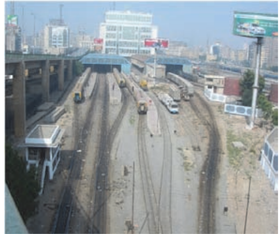
[カイロ駅] 日本の上野駅と同様に頭端ホームと通過ホームを備えた駅となっている
