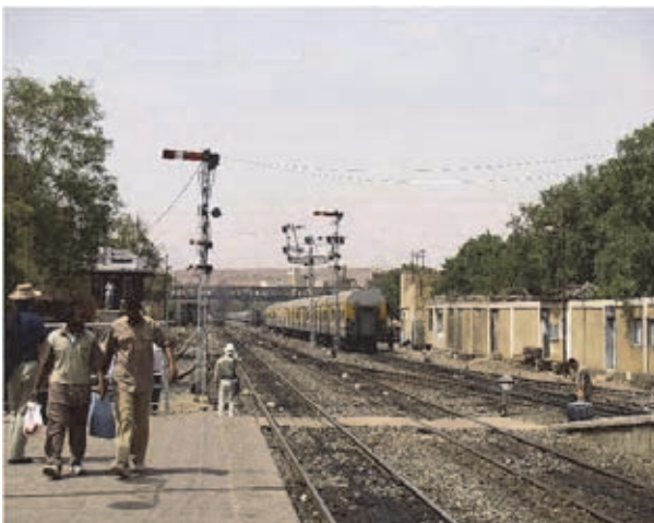
[アスワン駅構内の信号] 旧式な転轍てこを使った機械式運動装置によって列車制御が行われている
