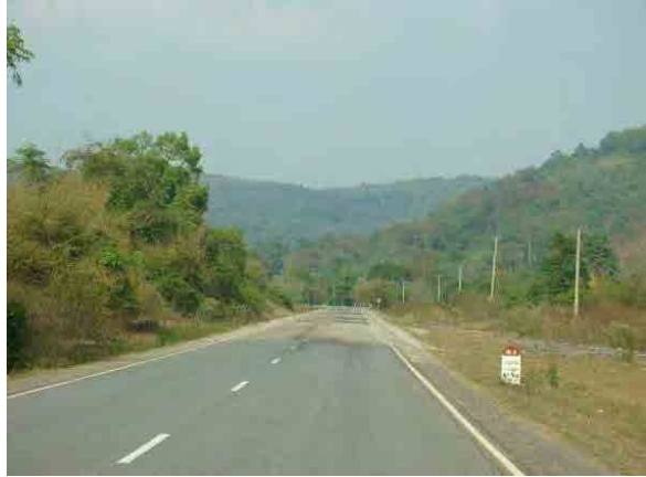
デンサワン付近 山間部を通り、道路は切土斜面が多く、線形は地形に沿ってカーブが多くなる
