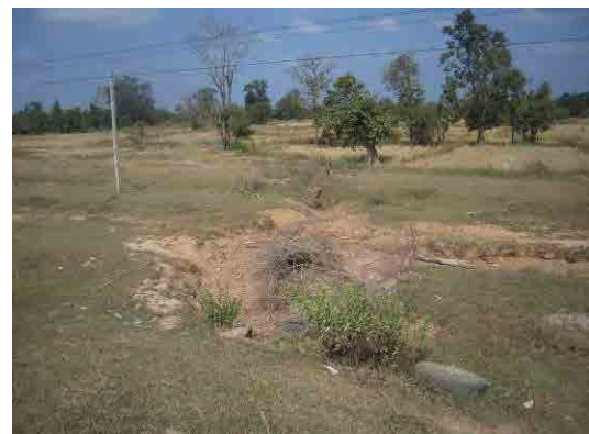
国道9号線より北側（推定地域排水不良発生区域）
