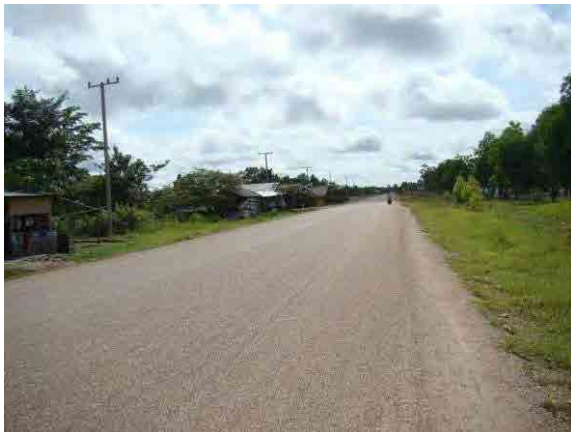
セノ付近 低地・平地を通り、切土・盛土がほとんどなく、線形も緩やか
