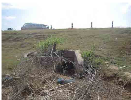
国道9号線に設置されたカルバート上流側
