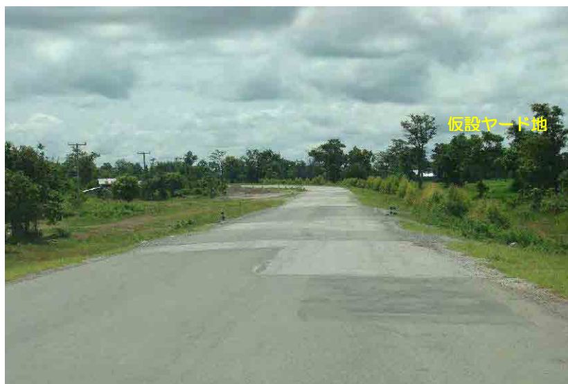
図 3.2.23 仮設ヤード候補地の状況（KM70 付近）
