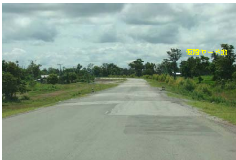
図 3. 2. 23 仮設ヤード候補地の状況（KM70 付近）
