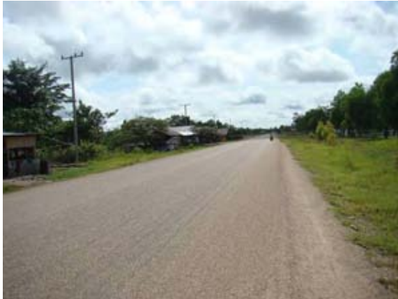
セノ付近 低地・平地を通り、切土・盛土がほとんどなく、線形も緩やか
