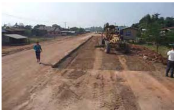
舗装損傷箇所の修復(1) 路面の損傷箇所をDBSTにより補修している
