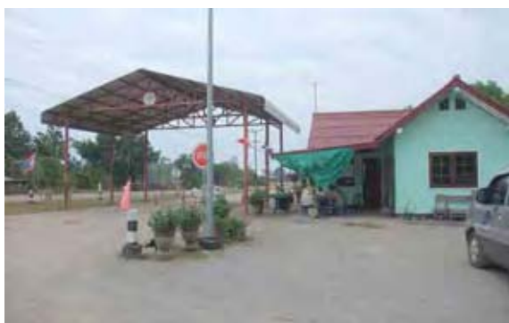
改修区間1内の車両軸重計測所
