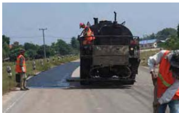
舗装損傷箇所の修復(2) 路面の損傷箇所をDBSTにより補修している
