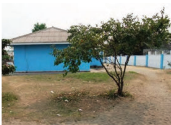
写真-1 対象敷地状況 (2010年8月) INPPK キャンパス内北西部に位置する対象敷地。敷地内の事務 宿舎棟は「コ」国側によって移転することが決まっている。
