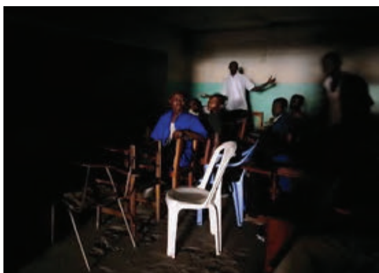
写真-5 自動車科講義室-2 一部の講義室は、開口面積の不足等により、照度の確保が非常 に難しい。
