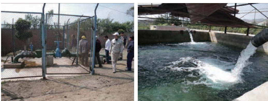
Foto 6.12 Situación del Pozo para Toma de Agua
