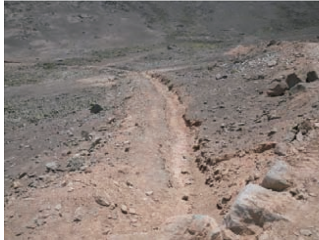
Foto 6.22 Imagen de la Construcción de los Canales de Coronación
