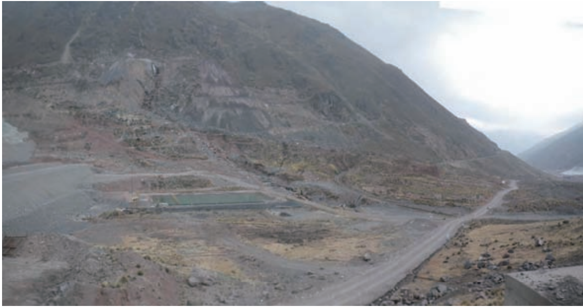
Foto 6.15 Estanque de Captación de Filtraciones del Dique de Relaves Chinchán
