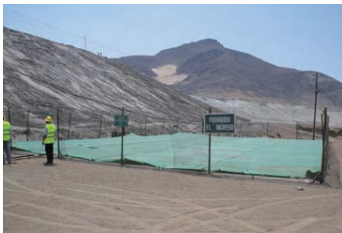
Foto 6.25 Tanque de Sedimentación de Agua Filtrada desde la Relavera
