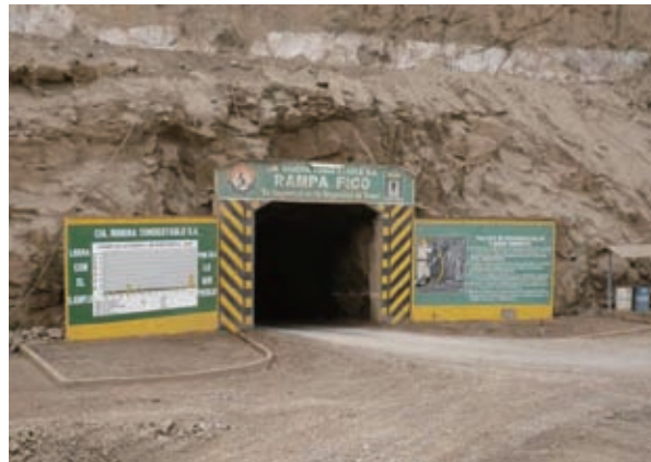
Foto 6.3 Situación de las Galerías
