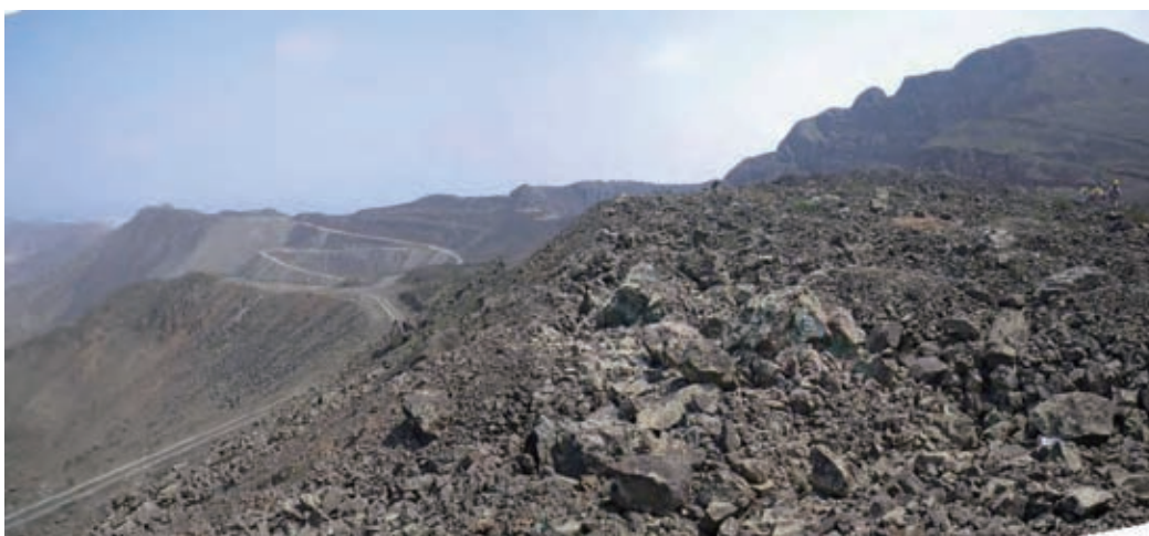
Foto 6.6 Estado del Talud del Botadero de Desmonte
