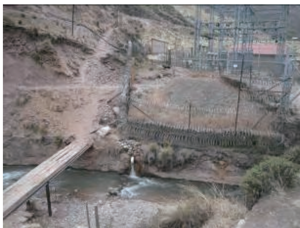
Foto 6.13 Drenaje de la Bocamina
