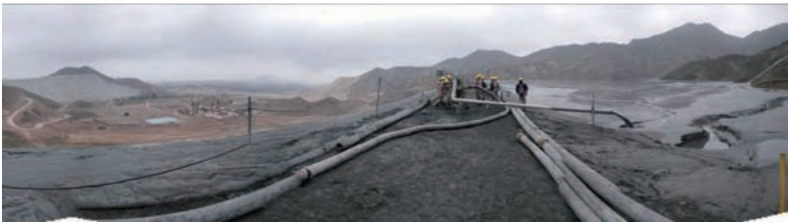
Foto 6.9 Situación de Uso del Dique de Relaves No.4
