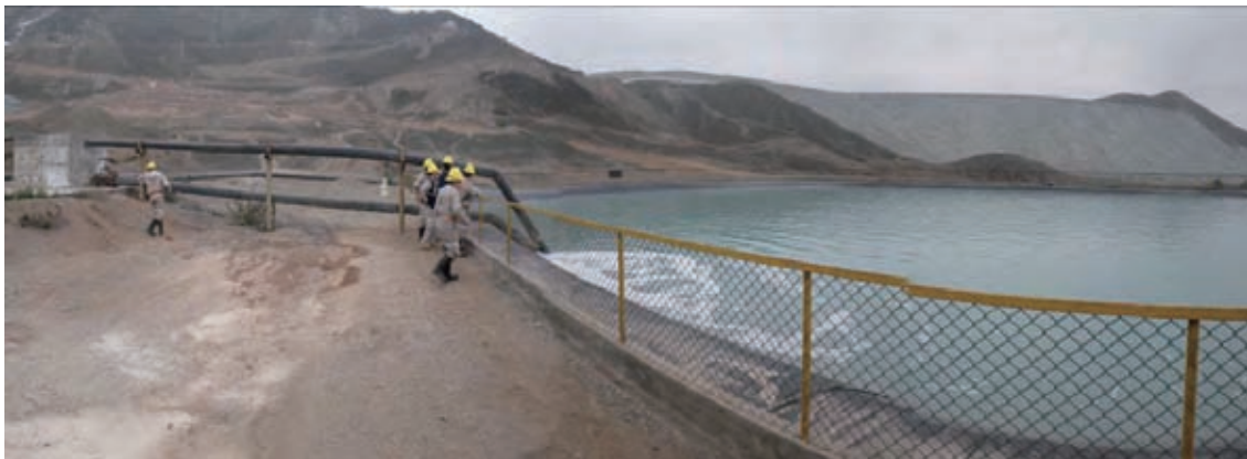
Foto 6.11 Estanque de Captación de Agua Filtrada del Dique de Relaves No.4
