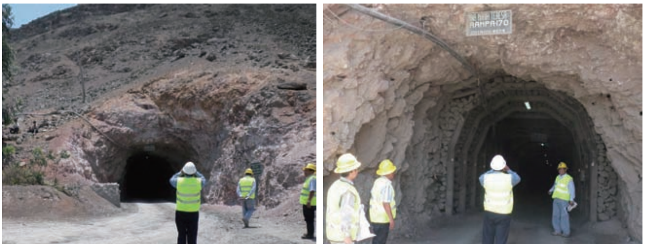
Foto 6.23 Situación de la Bocamina
