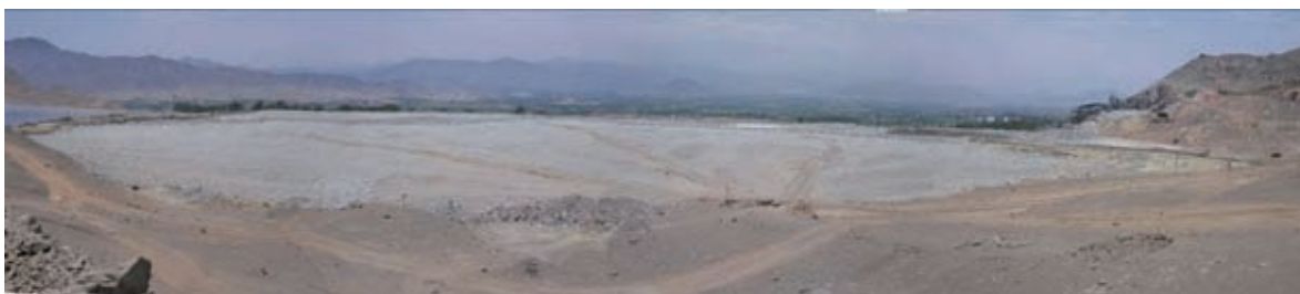
Relavera No.2 (en proceso de cierre progresivo)
