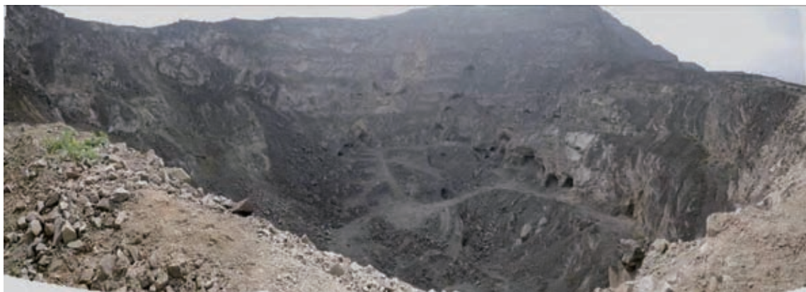
Foto 6.1 Situación del resto de la Explotación a Cielo Abierto (Tajo abierto resurrección)
