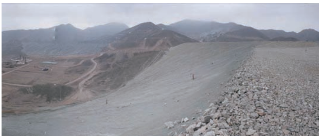
Foto 6.8 Estado de la Cobertura del Dique de Relaves No.2 de la Mina Condestable
