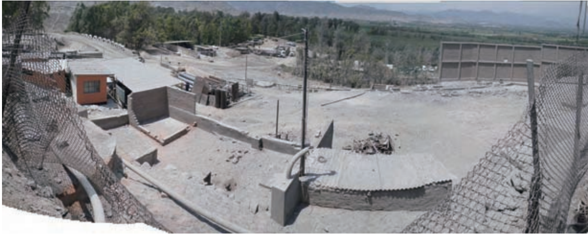
Foto 6.27 Instalación de Eliminación de Mercurio en Proceso de Cierre Progresivo
