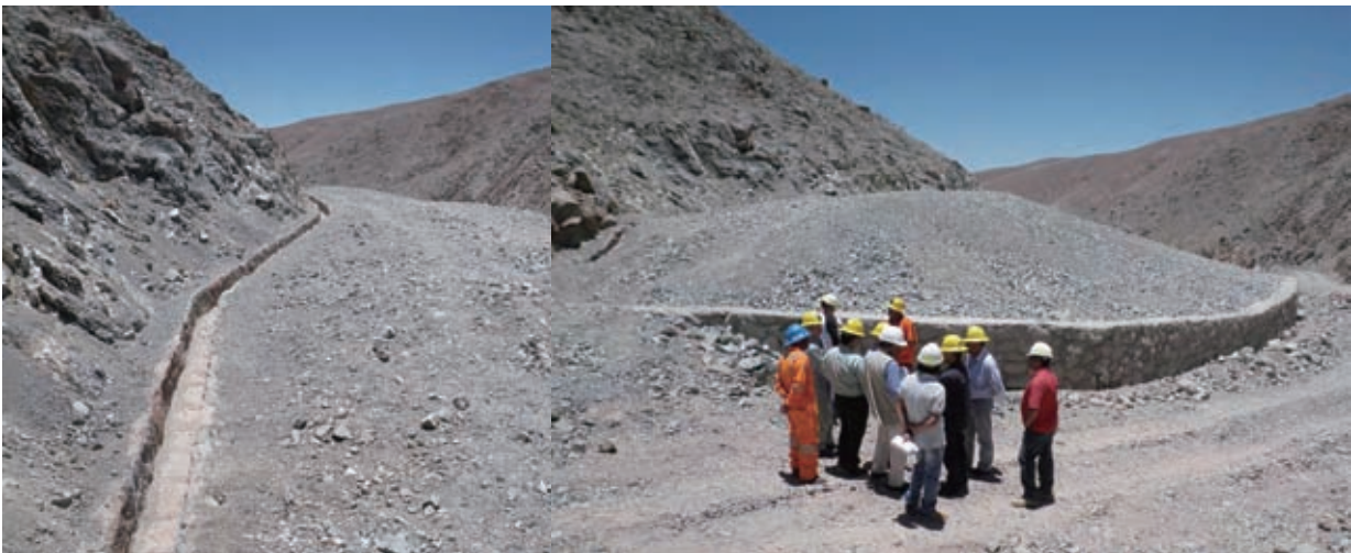
Foto 6.18 Botadero de Escombros y Canales de Coronación
