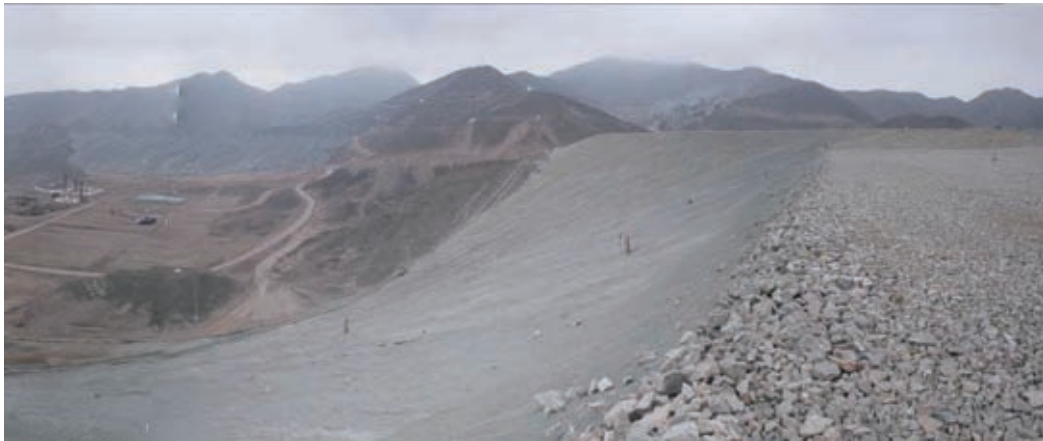
写真 6.8 Condestable 鉱山の No. 2 廃さい堆積場の被覆状況
