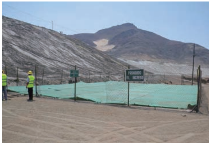
写真 6. 25 廃さい堆積場からの浸透水の沈殿池
