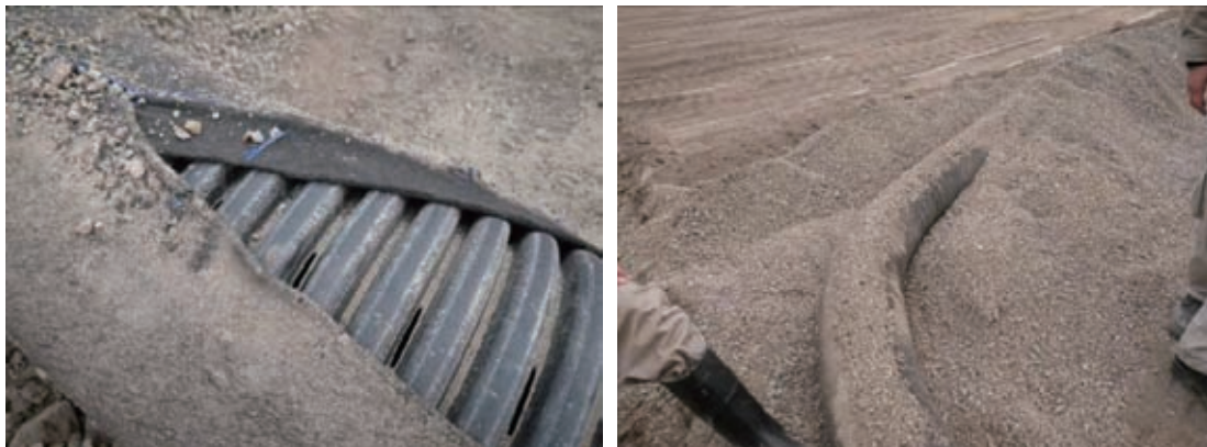
写真 6.10 No. 4 廃さい堆積場の集水設備
