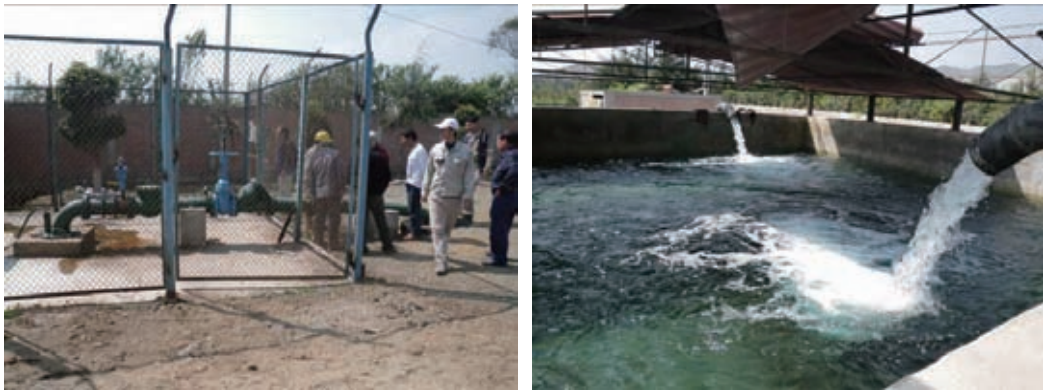
写真 6.12 取水井戸の状況
