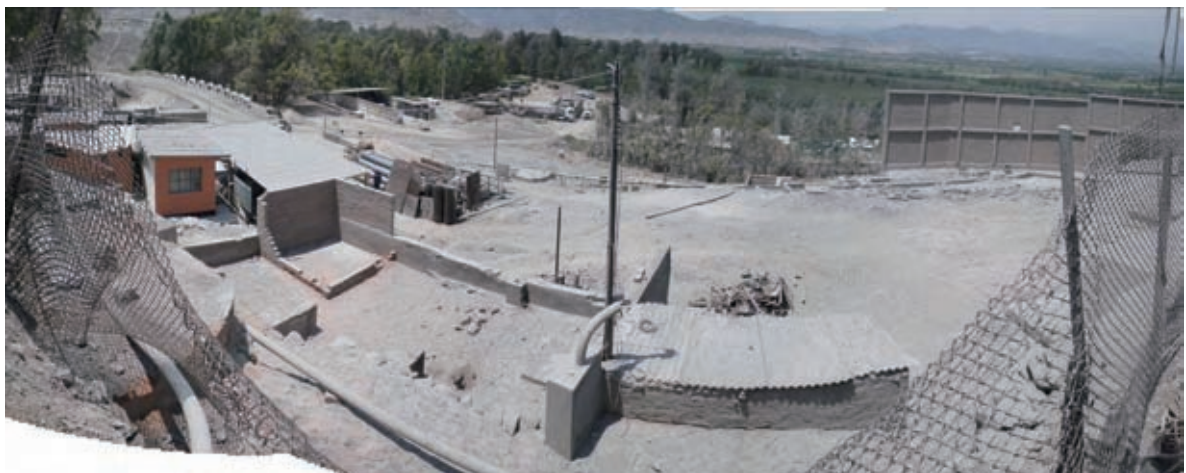
写真 6. 27 段階的閉鎖中の水銀除去設備
