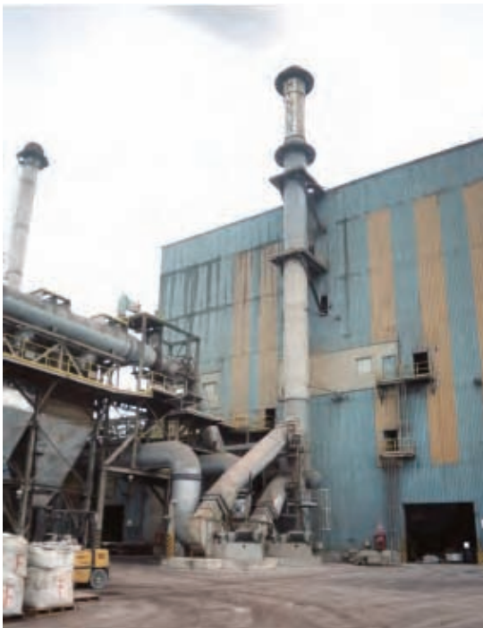
写真 6.20 煙突（高さ 40m）
