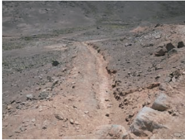
写真 6.22 山腹水路の建設状況
