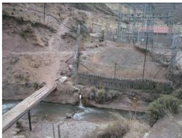
写真 6.13 坑口からの排水状況
