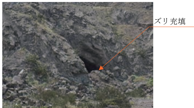
写真 6.2 坑口の閉鎖状況
