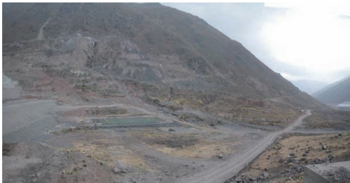
写真 6.15 Chinchán 廃さい堆積場の浸透水集水池
