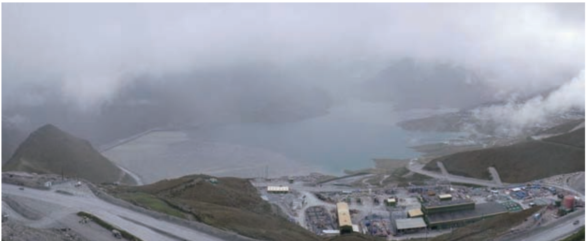
写真 6. 30 廃さい堆積場の状況
