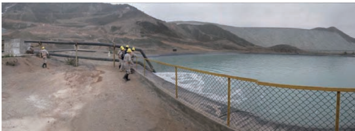
写真 6.11 No. 4 廃さい堆積場浸透水集水池
