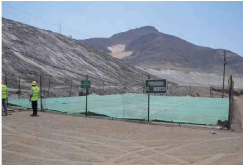
写真 6.13 廃さい堆積場からの浸透水の沈殿池
