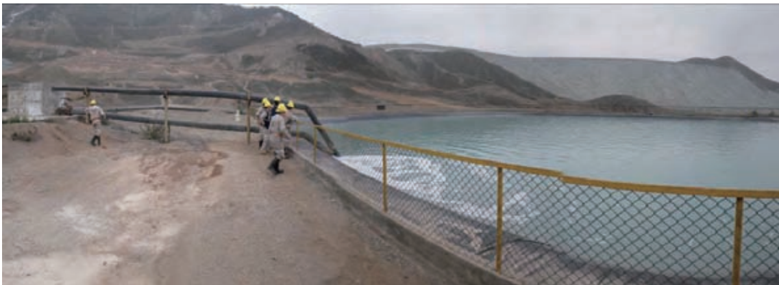
写真 6.5 No. 4 廃さい堆積場浸透水集水池
