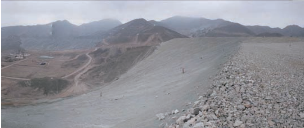
写真 6.4 Condestable 鉱山の No. 2 廃さい堆積場の被覆状況
