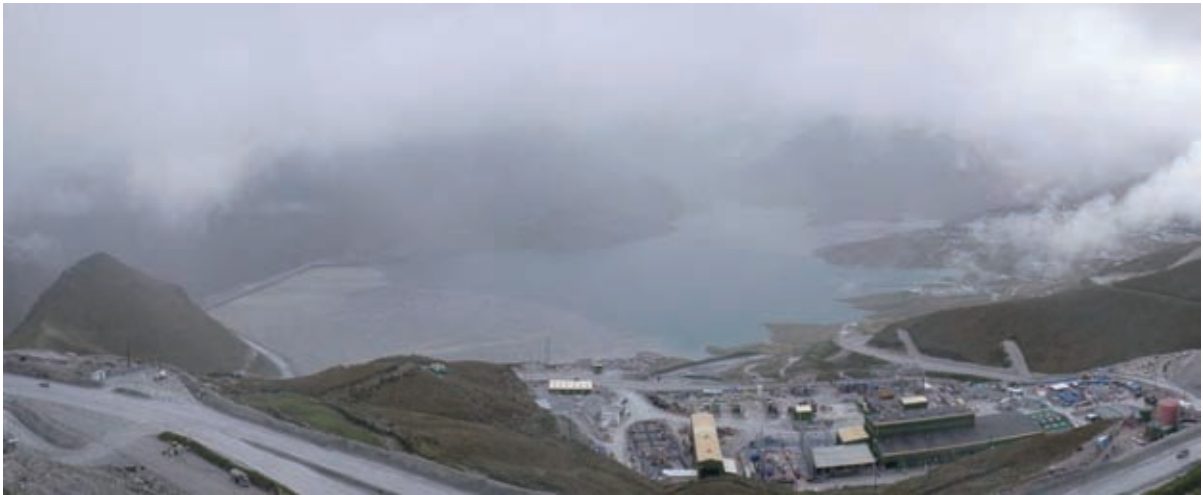
写真 6.18 廃さい堆積場の状況
