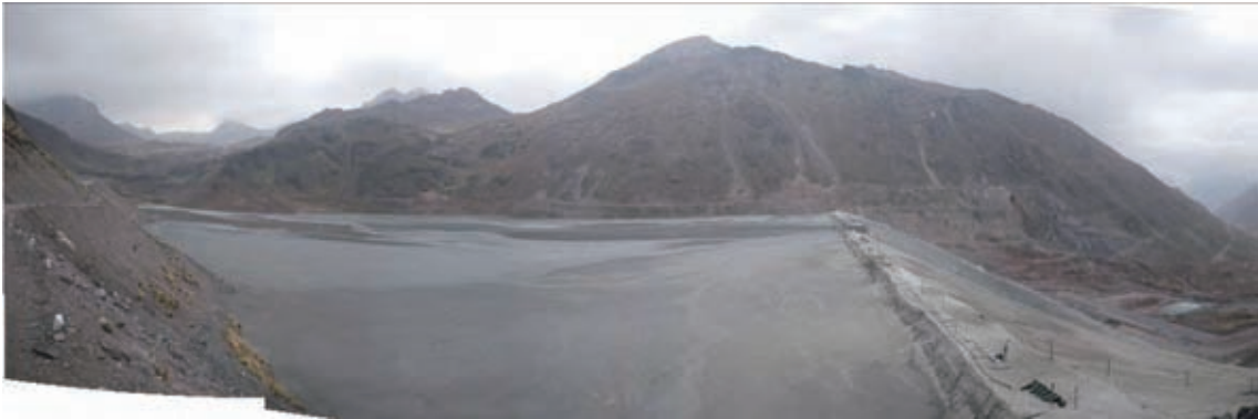
写真 6.7 Chinchan 廃さい堆積場の使用状況
