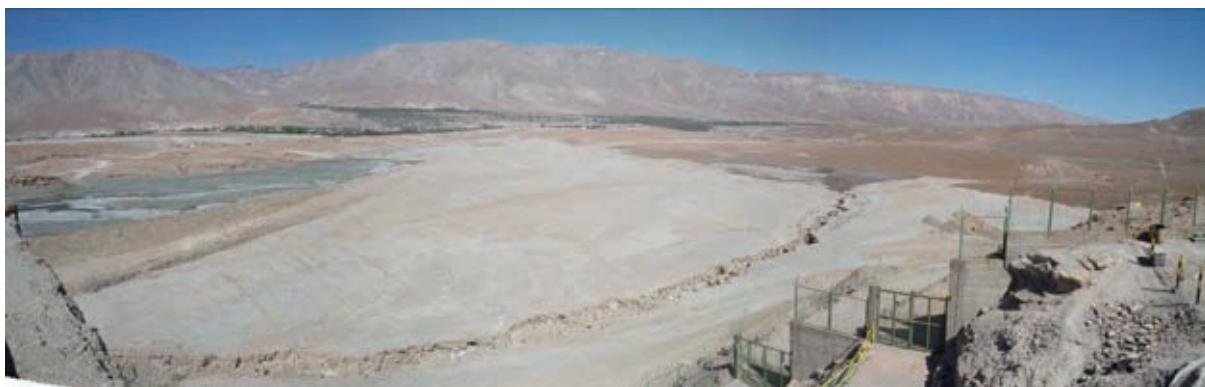
写真 6.10 廃さい堆積場
