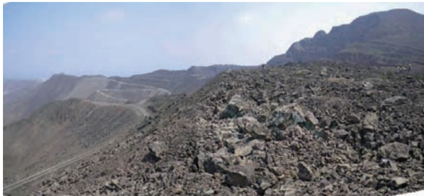
写真 6.2 ズリ捨場の法面の状況
