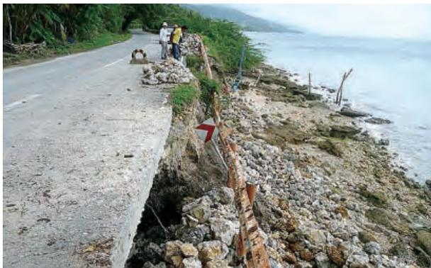
セブ島西南海岸沿いの国道 (R-VII) ・Alegria 町：DPWH- リージョン VII パイロットプロジェクト候補地の二つ目。護岸工のリップラップが崩れ、舗装下が洗い流されている。
