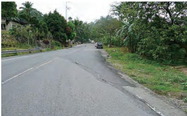
Naga-Uling 道路 (R-VII) ・地滑り対策工候補地：DPWH- リージョン VII パイロットプロジェクト候補地の一つ目。地滑り対策工として、水抜きボーリングが計画された。路面に沈下が確認され、オーバーレイにより対処されている。
