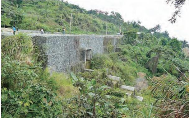
日比友好道路の地滑り箇所への復旧状況①：2010年発生した地滑り災害に対し、ギャビオンマット（布団籠）を中心とした工法により普及している。ほぼ鉛直に積み上げたギャビオンマットは、斜面構造安定上不安を与えるだけでなく、山側の排水並びに谷側の排水構造は、十分な安全性を考慮した設計であると証明できているのか。
