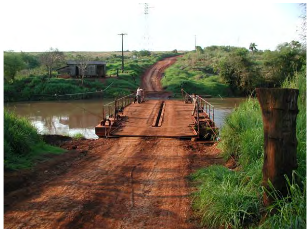
Pontón que atraviesa el río Ñacunday (Camino en la ribera del río Paraná)
