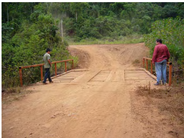
Puente que atraviesa el camino de acceso al puerto de Torocua
