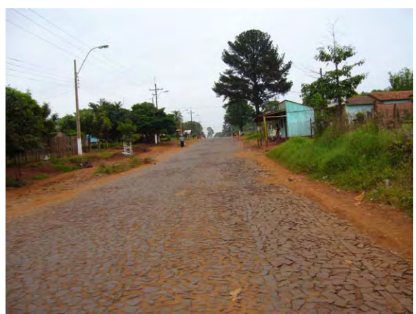
Tramo empedrado típico en la cercanía de Ciudad del Este (Camino en la ribera del río Paraná)
