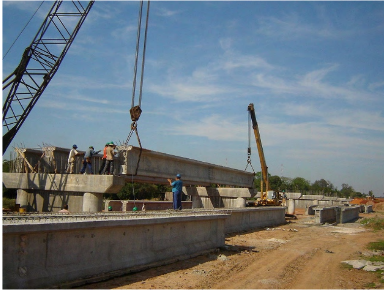
Foto 8.2-1 Situación de la Construcción Mediante Grúa Montada en Camión
