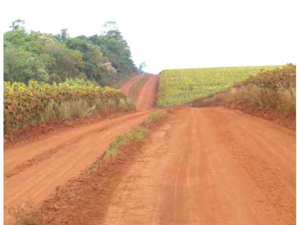
Camino de acceso al puerto Torocua con gran desnivel
